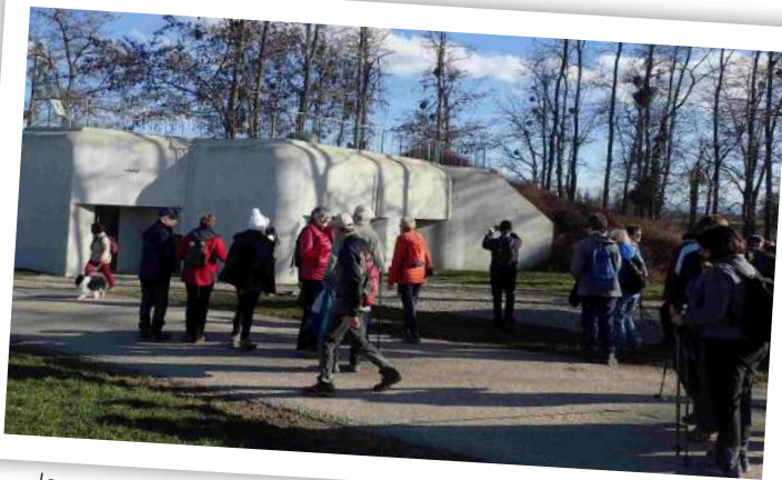
la casemate bien restaurée de la ligne Maginot
